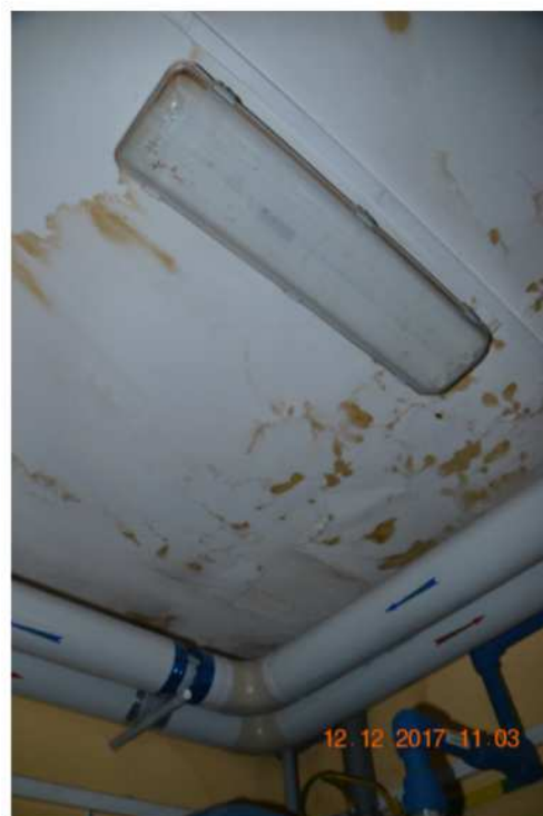
Fot.39 Kotłownia. Sufit z przeciekem z wyższej kondygnacji.
