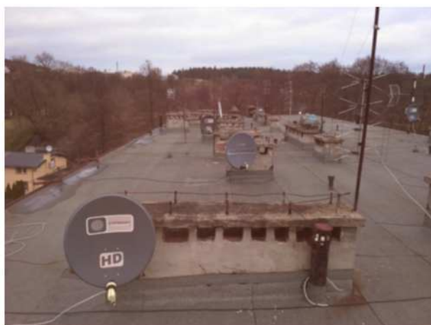
Fot.40 Dach. Pokrycie - nowa papa. Kominy czapy kominów zniszczone - należy je zabezpieczyć przed przeciekami.
