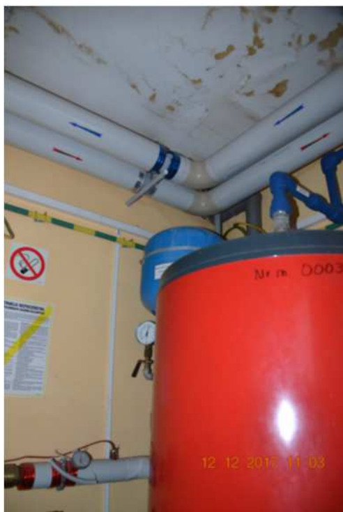
Fot.38 Kotłownia - parter. Strop z widocznym przeciekem z I pietra.
