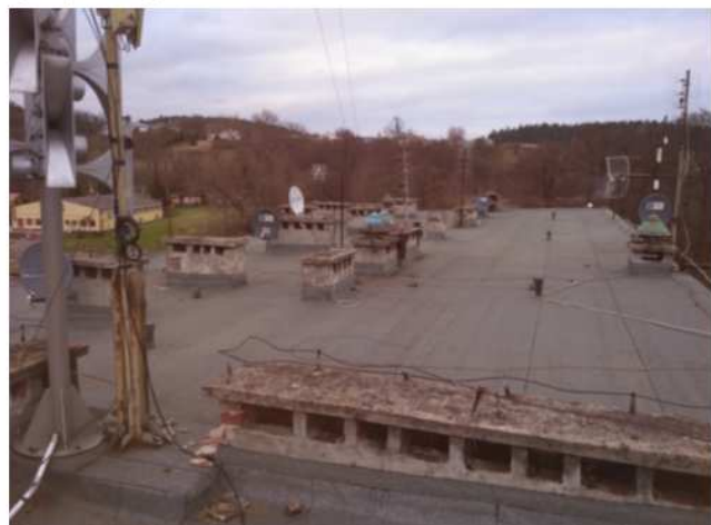
Fot.43 Dach. Kominy są podstawą przecieków. Należy zabezpieczyć czapki kominów przed przeciekami. Najlepiej pokrywając czapki kominów - papa termozgrzewalna.
