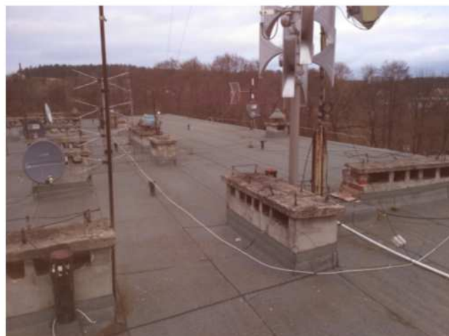
Fot. 41 Pokrycie na dachu - DOBRE. Kominy - do remontu. Czapki kominów należy zabezpieczyć papa przed przeciekami.
