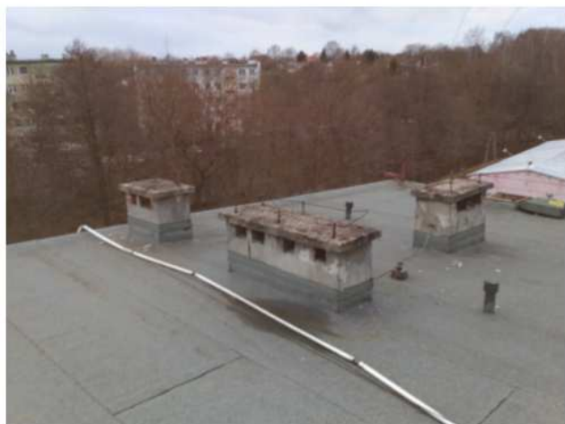
Fot. 42 Pokrycie z papy termozgrzewalnej jest DOBRE. Kominy (czapki kominów) - należy zabezpieczyć przed opadami deszczu.
